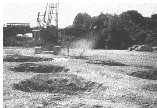
Figure 9 – Chantier de pilonnage
