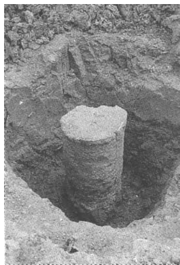
Figure 6 – Colonne de sol traité à la chaux
